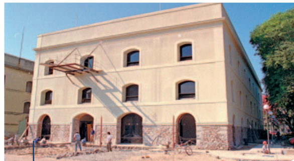
Depósito Santos en reparación. Fecha: 17 de abril de 1997.
