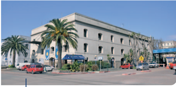
Edificio Santos, futura Terminal de Cruceros de Montevideo.
