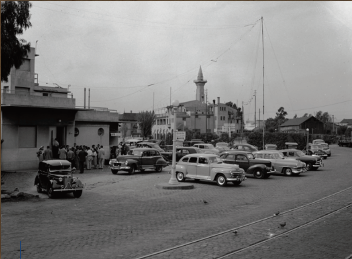
Vista del estacionamiento en el Hidropuerto CAUSA ocupado por numerosos vehículos por la llegada y salida de pasajeros.
