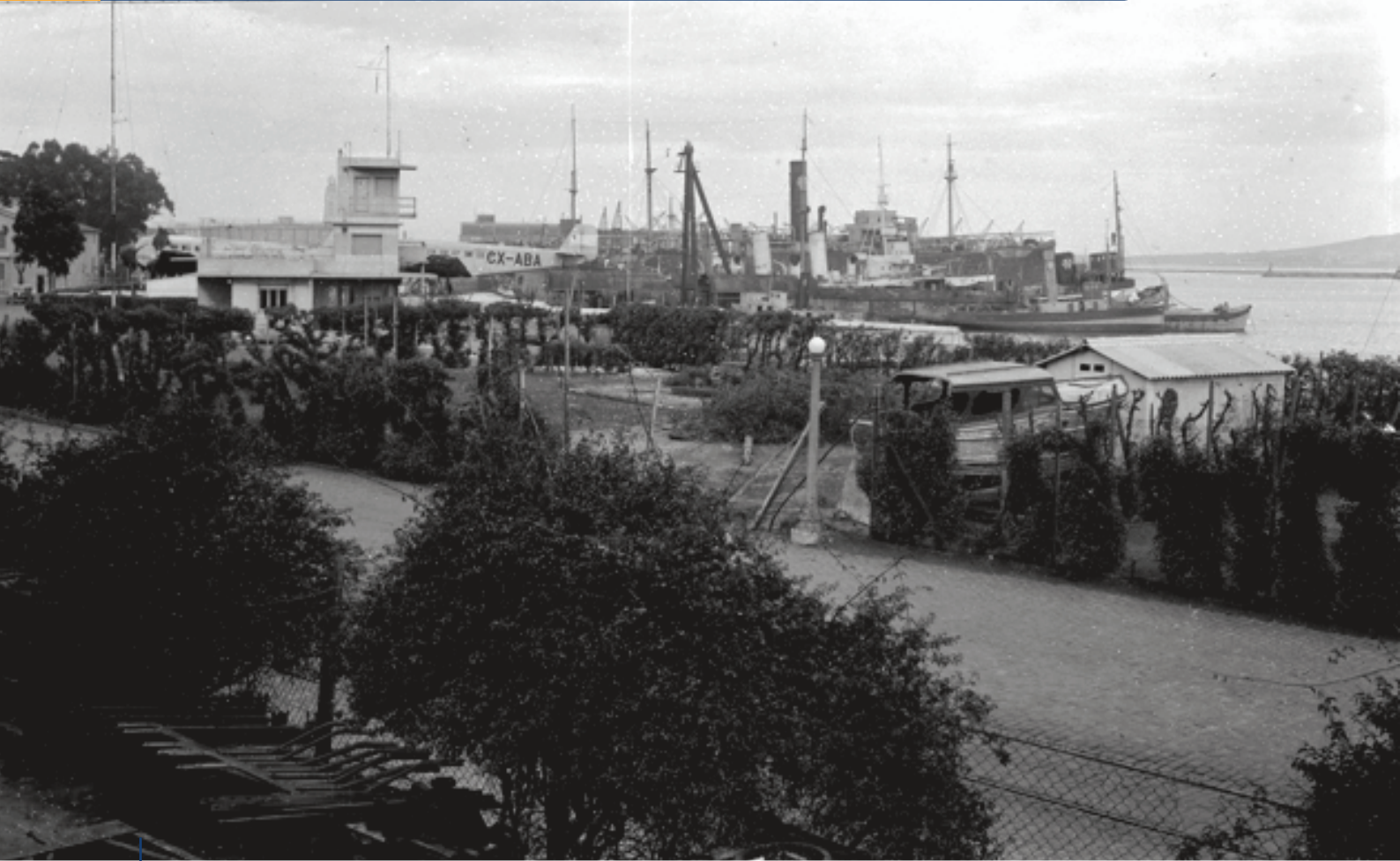
Vista general del Hidropuerto y edificio sede de CAUSA.
