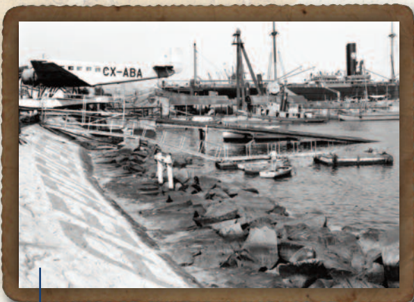
Vista del Hidropuerto de CAUSA con balsas y pasarelas viejas que fueron sustituidas por las de hormigón. Puerto de Montevideo.
