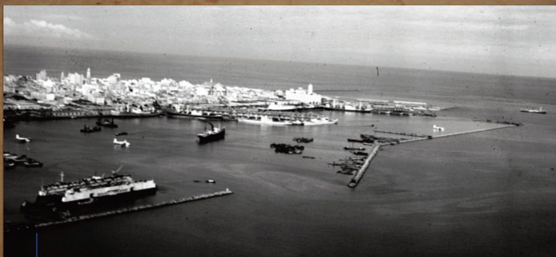
Vista aérea desde helicóptero hacia el oeste. Primer plano: dique flotante de 16.000 ton y espigón F. En segundo plano la Dársena II y el Muelle B. Tercer plano la Dársena I y Muelle A. ultimo plano Dársena Fluvial y Muelle de Escala. A la derecha el dique de cintura y el antepuerto. A la izquierda la Ciudad Vieja.
