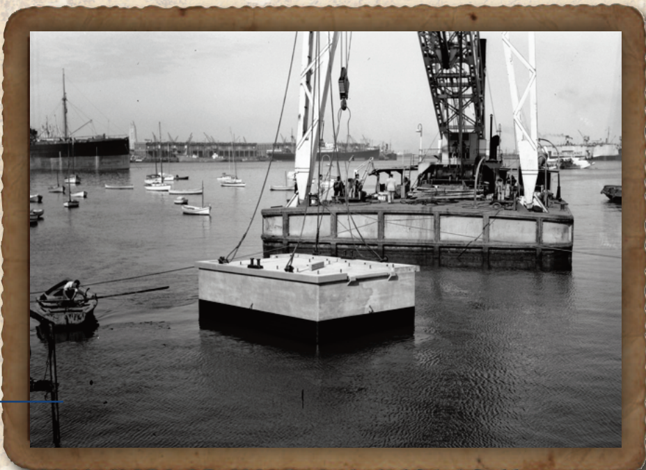
El pontón, ya en el agua, fue remolcado con la Grúa Flotante General Artigas, para colocarlo en su lugar del Hidropuerto.
