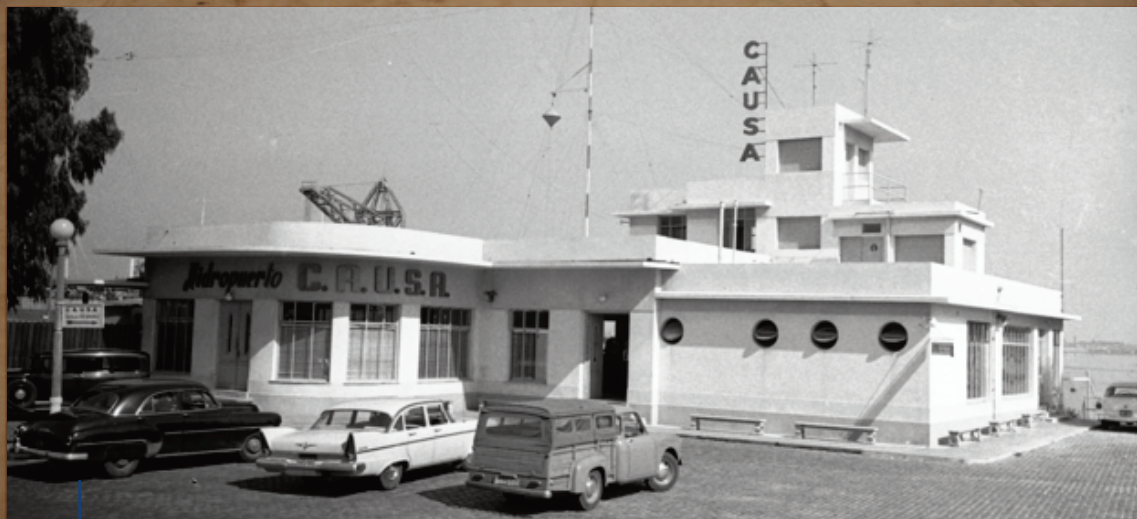
Hidropuerto CAUSA vista exterior.
