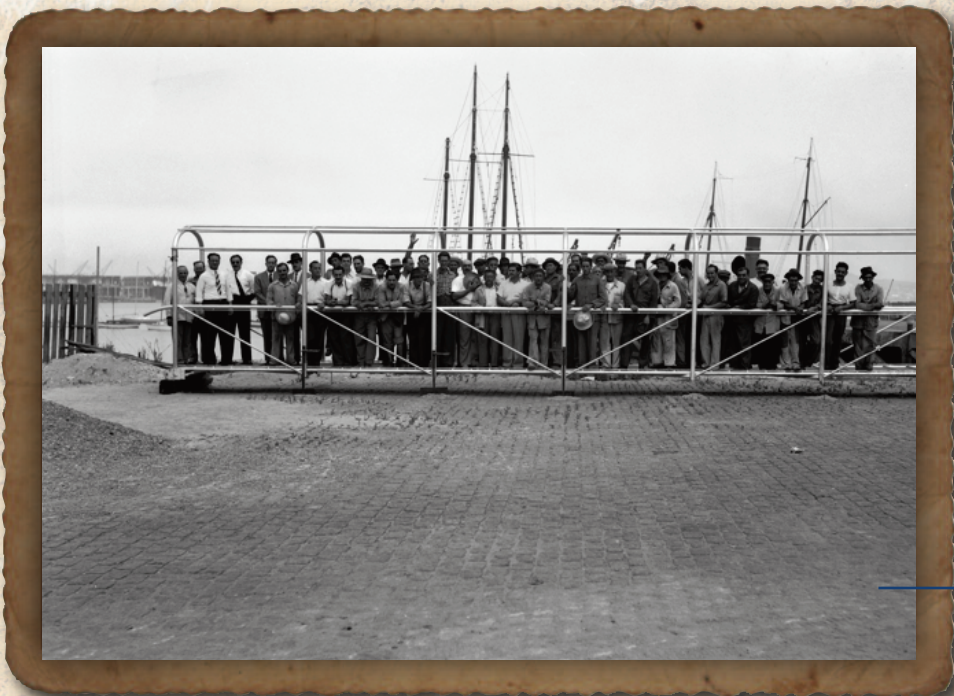
Prueba de la pasarela que unió a los dos pontones flotantes.
