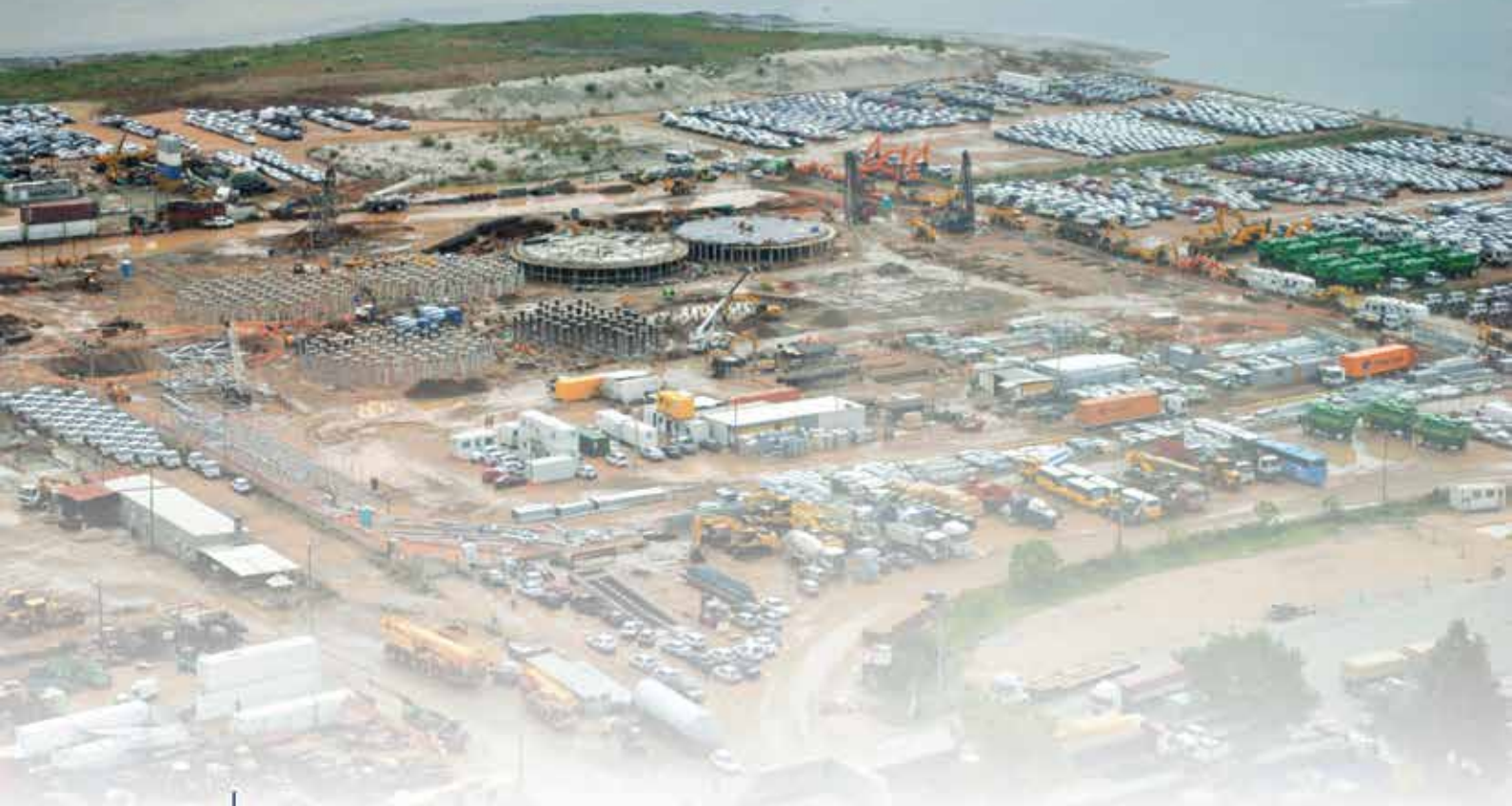
Obras de la nueva Terminal de graneles y chips de madera en el Puerto de Montevideo.
